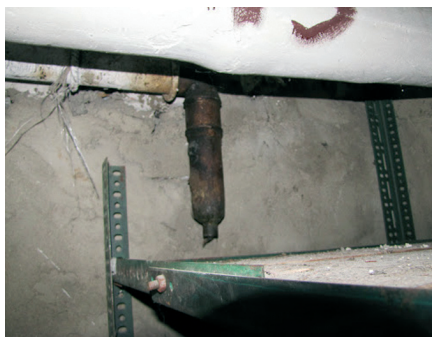
1, 2. Typowe zaniechania instalacji gazowej pomimo wykonywania corocznych przeglądów: w rurkę gazową, w miejsce wycieku gazu po prostu wkręcono śrubę
