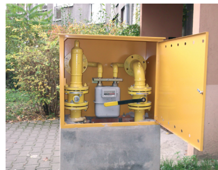
9, 10. Budynek Spółdzielni Mieszkaniowej Karłowice we Wrocławiu. Zgodnie z zaleceniami protokołu zlikwidowano KT z licznymi zaworami i długimi gwintami oraz przeniesiono zawór główny i gazomierz na zewnątrz budynku
