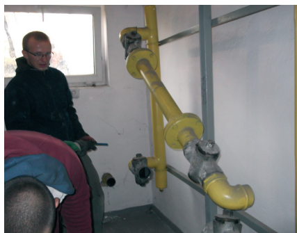
9, 10. Budynek Spółdzielni Mieszkaniowej Karłowice we Wrocławiu. Zgodnie z zaleceniami protokołu zlikwidowano KT z licznymi zaworami i długimi gwintami oraz przeniesiono zawór główny i gazomierz na zewnątrz budynku
