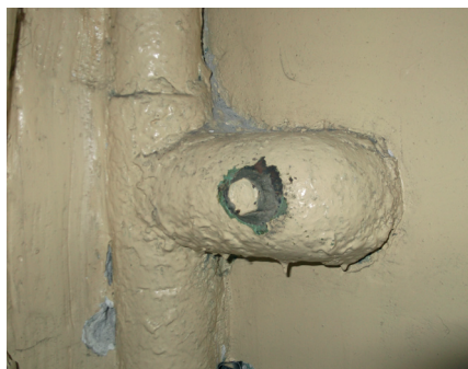
1, 2. Typowe zaniechania instalacji gazowej pomimo wykonywania corocznych przeglądów: w rurkę gazową, w miejsce wycieku gazu po prostu wkręcono śrubę
