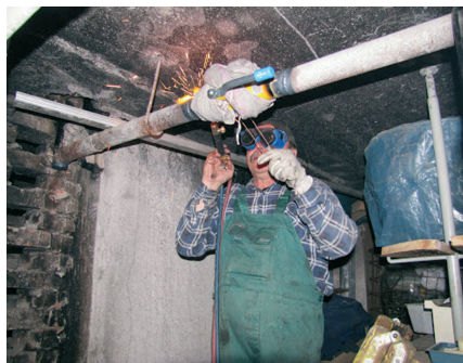
11, 12. Legnicka Spółdzielnia Mieszkaniowa. W budynku konieczna była likwidacja elementów starej instalacji: zaworów stożkowych, długich gwintów i odwadniaczy (część wspólna instalacji gazowej) oraz wykonanie konserwacji zaworu głównego (przez zakład gazowniczy)
