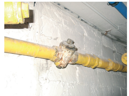
11, 12. Legnicka Spółdzielnia Mieszkaniowa. W budynku konieczna była likwidacja elementów starej instalacji: zaworów stożkowych, długich gwintów i odwadniaczy (część wspólna instalacji gazowej) oraz wykonanie konserwacji zaworu głównego (przez zakład gazowniczy)
