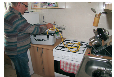
14. Wykonanie przeglądu instalacji gazowej z ups przy zastosowaniu urządzenia ComTec
